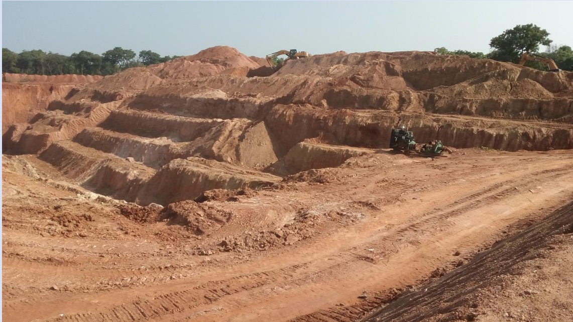
Photo 33 : Machines mécaniques et pelleuses de l'entreprise Thien Pao.
